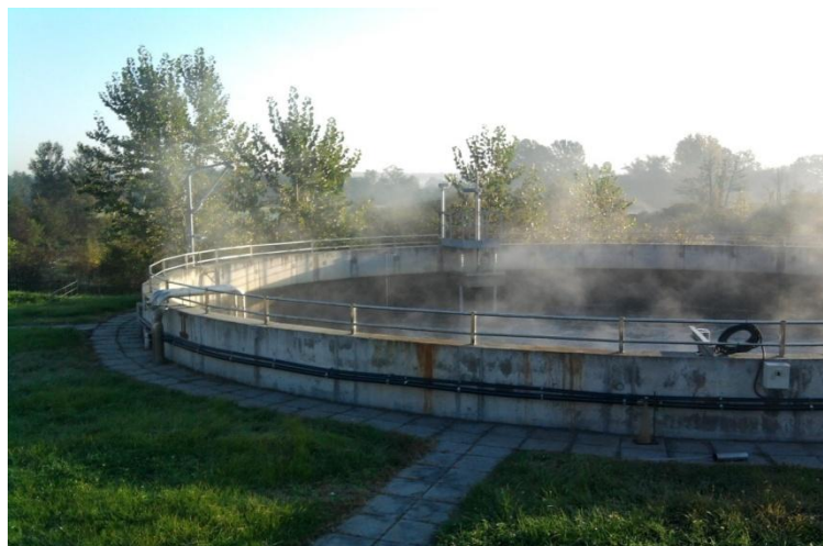
1. Kép. Az SBR1 medence képe, hajnalban, szennyvízfogadás közben.
