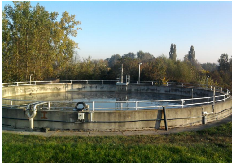
2. Kép. Az SBR medence képe, ülepítéskor, tisztított víz elvétel előtt.
